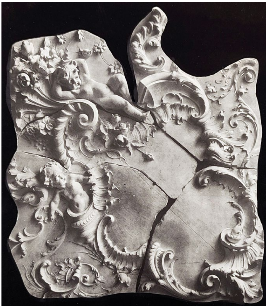
Fig. 5_Pezzi preformati, accostati a formare il motivo decorativo. Dopo la posa in opera l'intervento dello stuccatore rifinisce e maschera i giunti. Da MUSSO F.LLI E PAPOTTI, Plastica ornamentale , serie I, Torino, Molfese, [19..], tav. 29.
